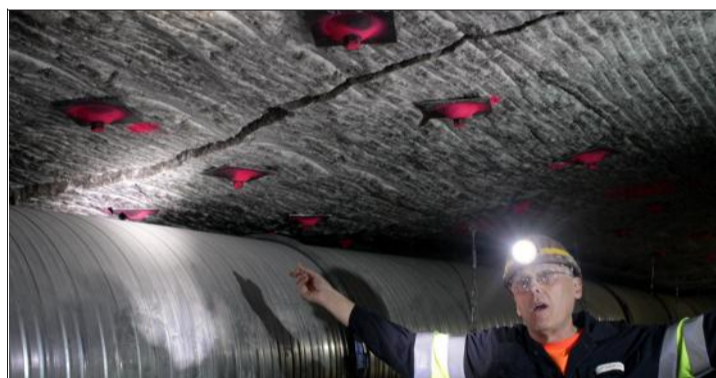
Alain Rollet, liquidateur des MDPA et président de Stocamine, estime que la dégradation des terrains miniers pourrait remettre en cause le stockage souhaité par le ministère.
