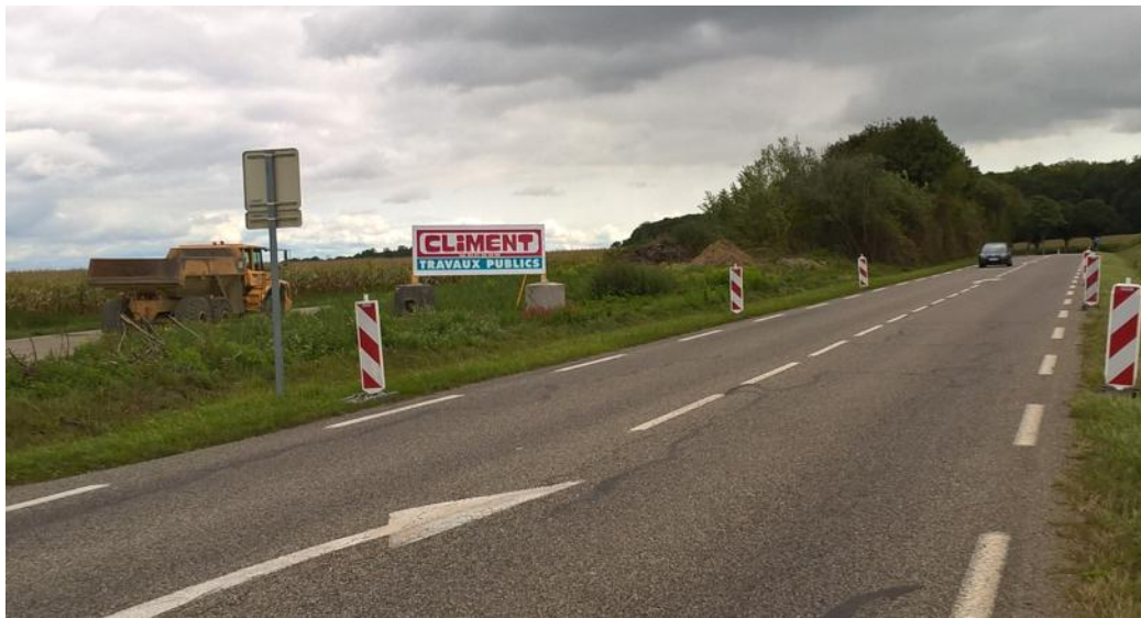
Le futur rond-point en direction d'Altkirch... PHOTOS DNA
